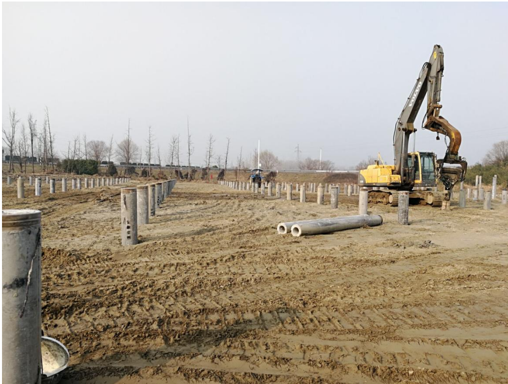
图 5 南沈打桩(部分桩已打至标高高度)
