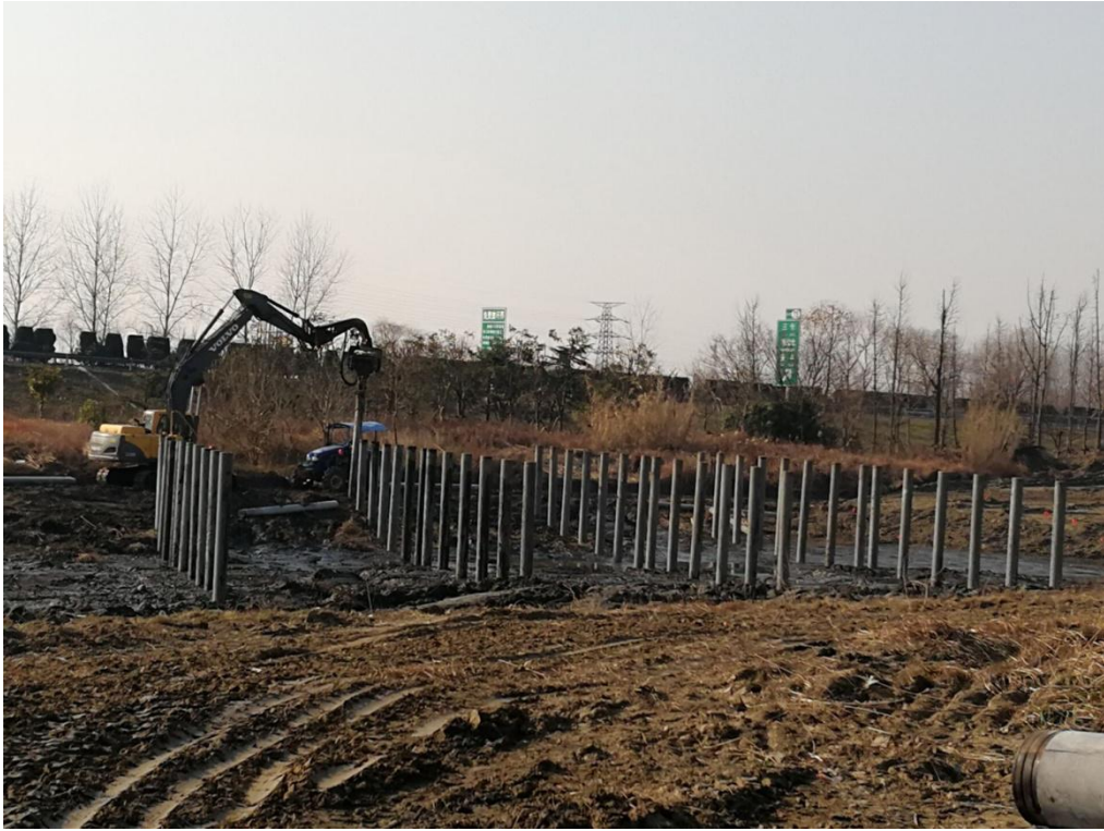
图 3 南沈灶试打桩
