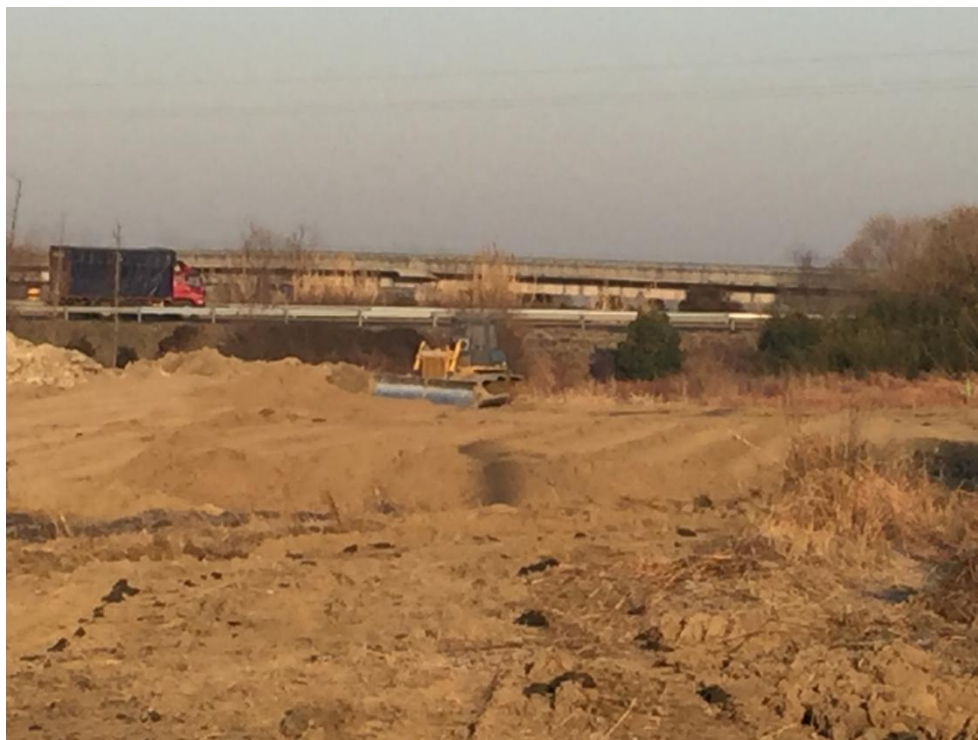
图 1 南沈灶土坡平整
