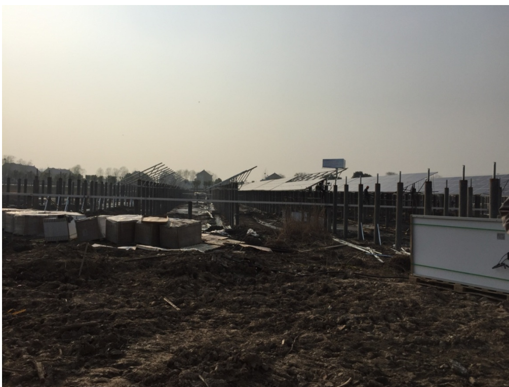
白蒲支架安装
