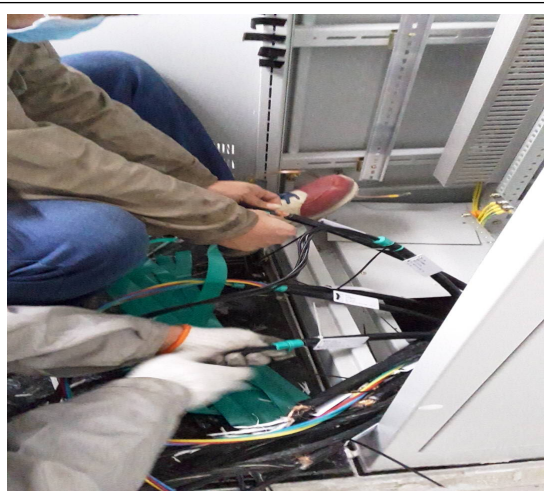
开关站二次室内电气设备接线施工
