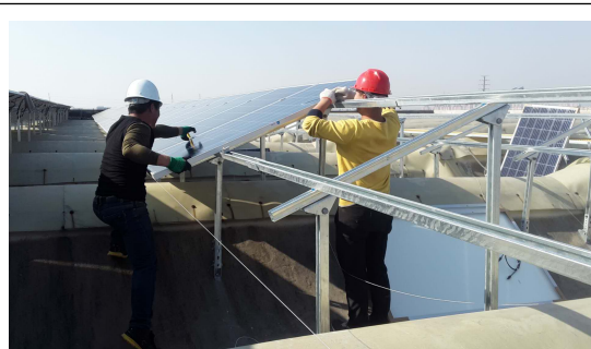
光伏区 4#屋顶支架、组件安装
