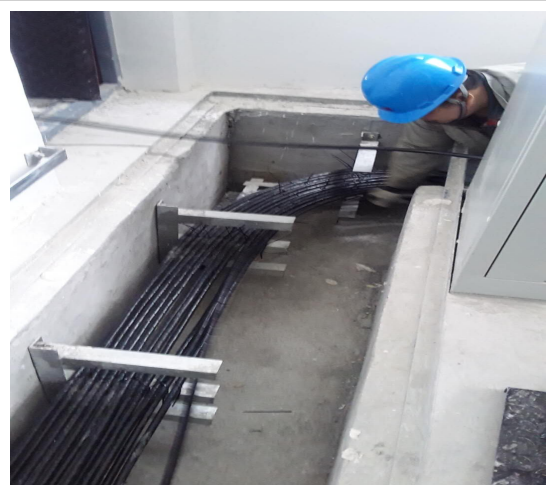
开关站室内电缆沟电缆敷设
