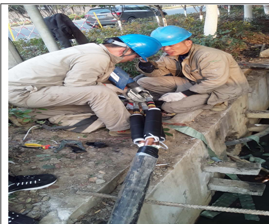
高压电缆中间接头制作
