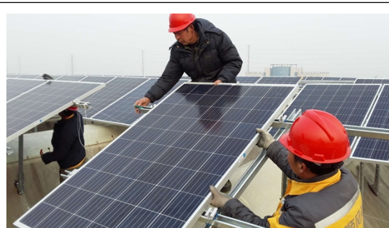
光伏区 4#屋顶支架、组件安装
