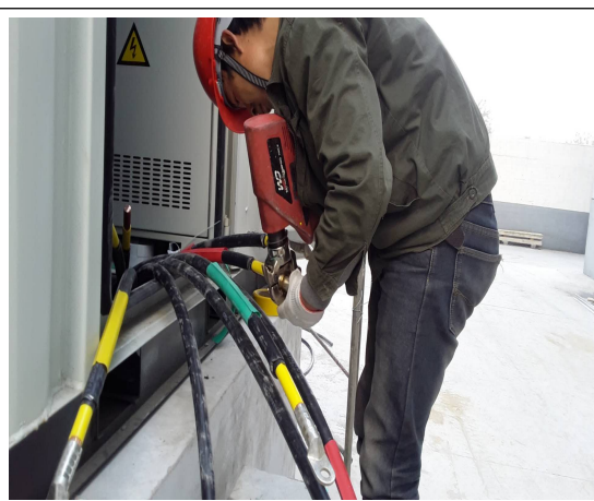
逆变器设备电缆终端头制作
