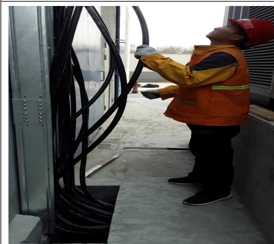
光伏区 6#厂房外侧墙面电缆敷设
