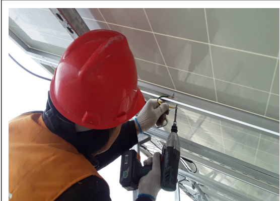
光伏区 4#厂房屋顶光伏板接地线安装
