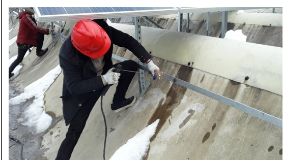
光伏区 2#厂房屋顶支架接地扁铁焊接
