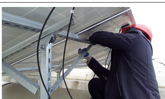
光伏区 6#厂房屋顶支架斜撑安装
