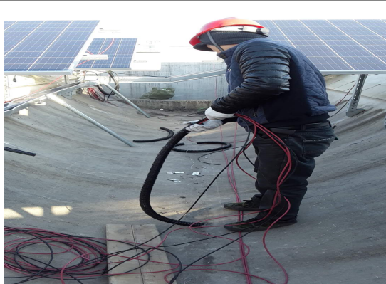
光伏区 4#厂房屋顶直流电缆穿管施工
