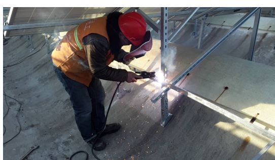
光伏区 6#厂房屋顶支架接地扁铁焊接
