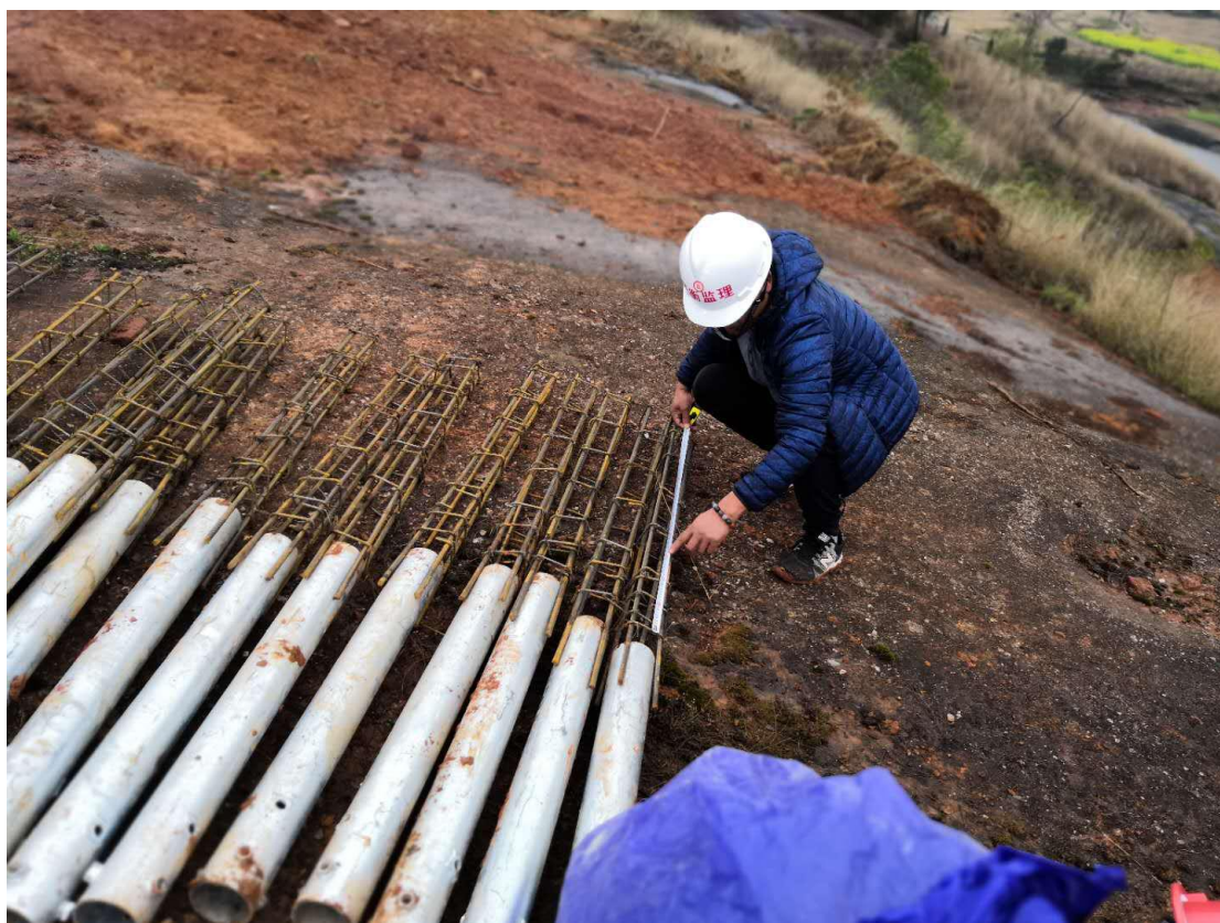
监理现场对钢筋笼检查
