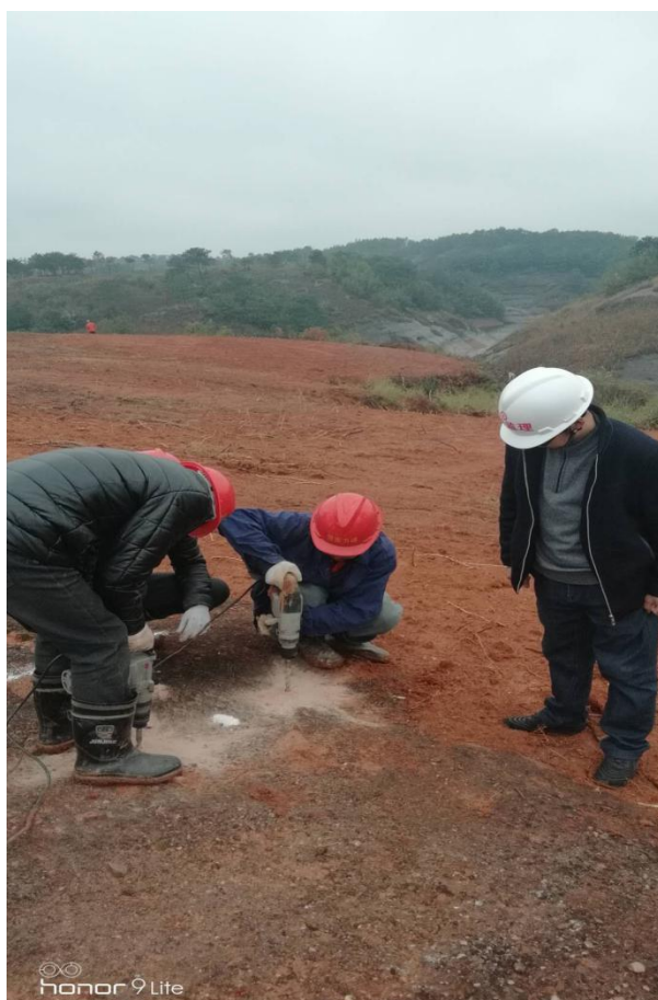
监理对植筋基础检查
