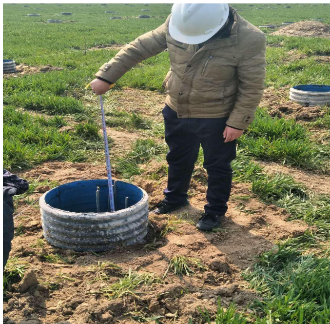
一区桩基础引孔深度测量
