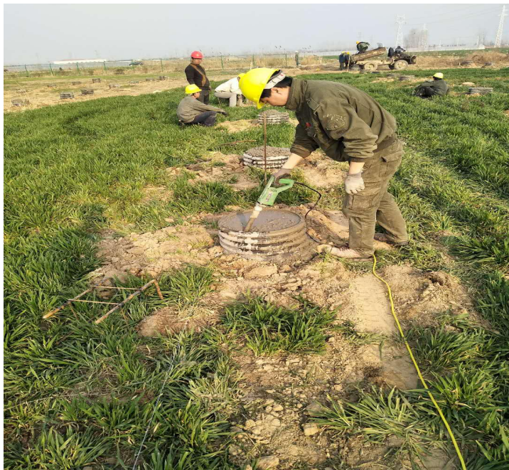
二区桩基础混凝土振捣
