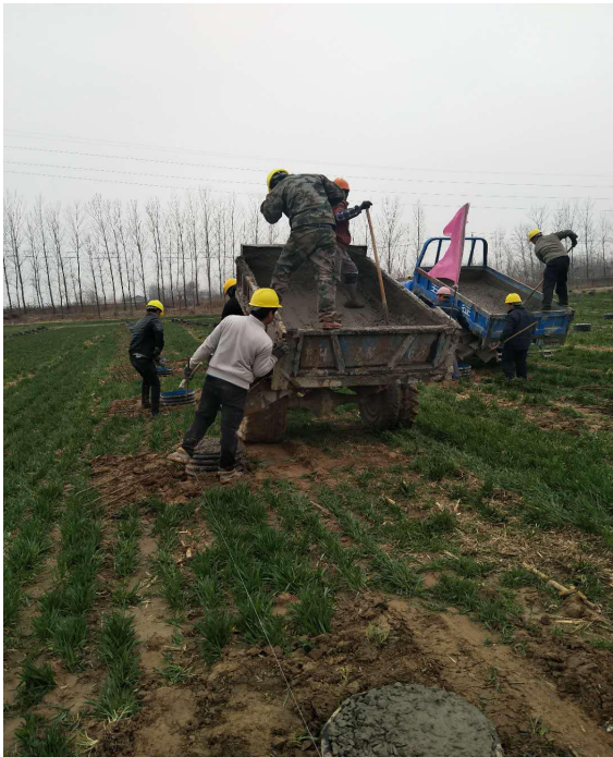
一区桩基础混凝土浇筑
