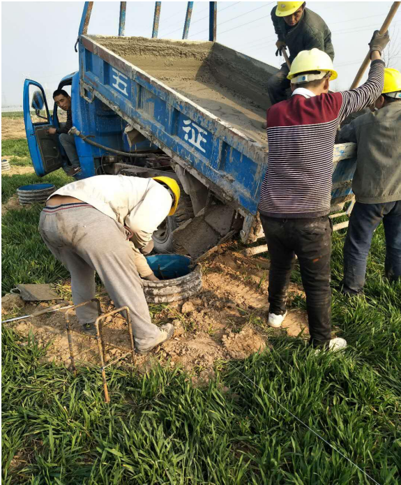
二区桩基础混凝土浇筑
