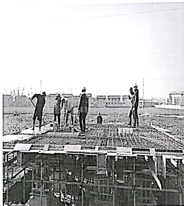
光伏区箱逆变基础混凝土浇筑
