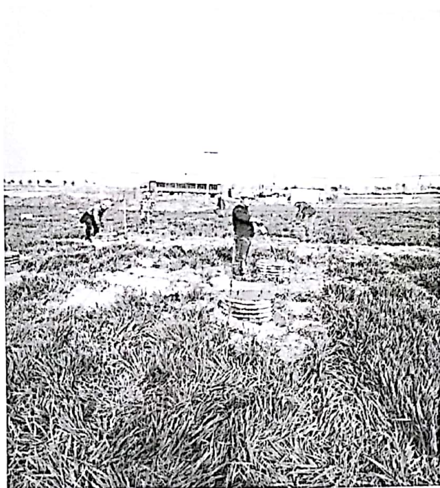
光伏区桩基础混凝土浇筑
