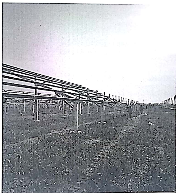
光伏区支架安装
