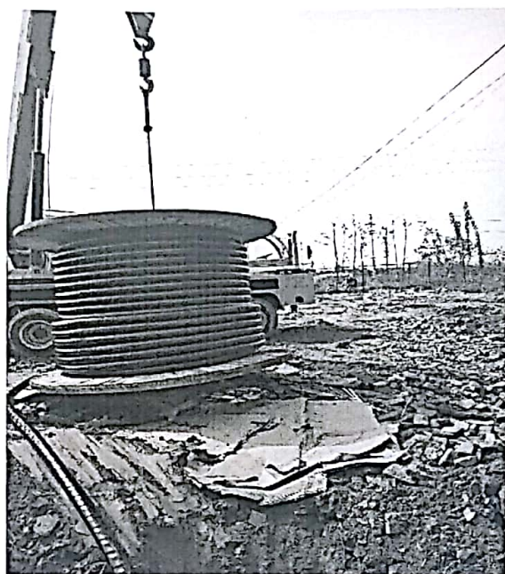
光伏区高压电缆敷设
