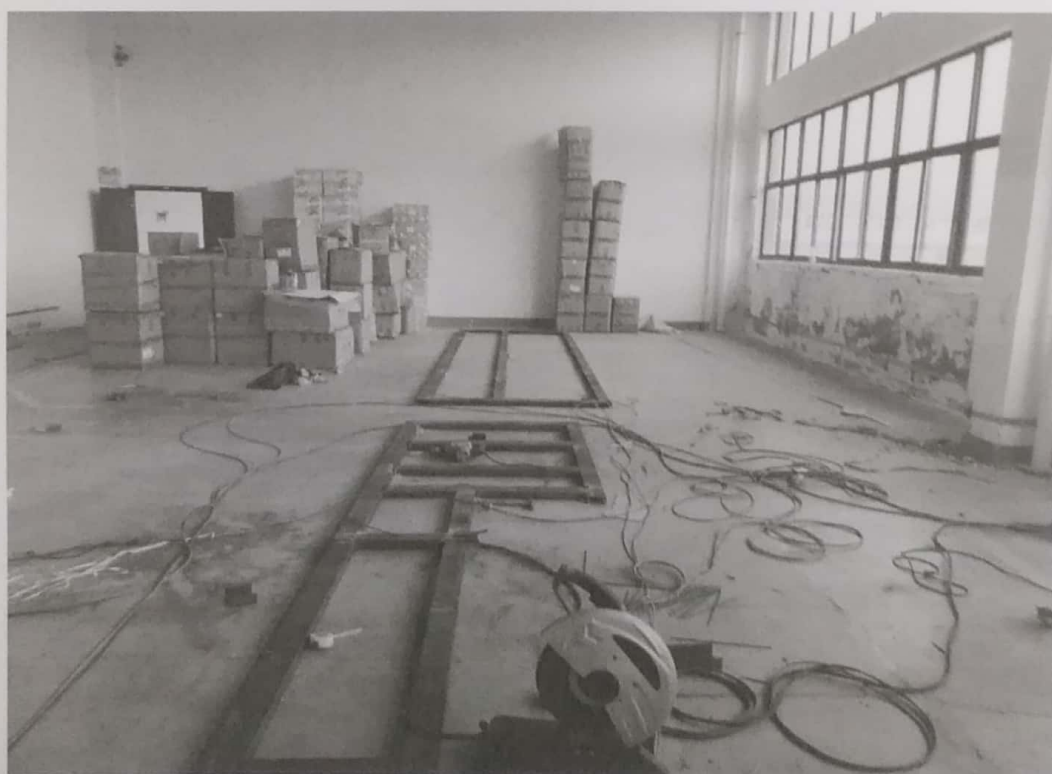
配电柜底座制作
