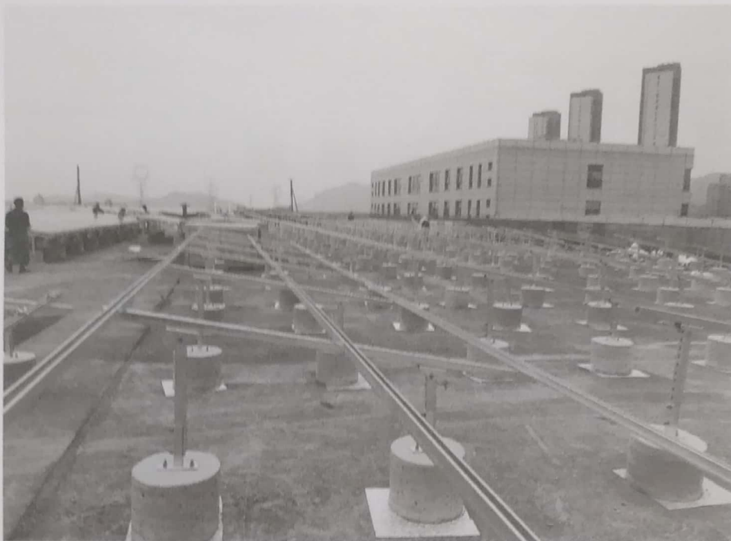
光伏支架安裝
