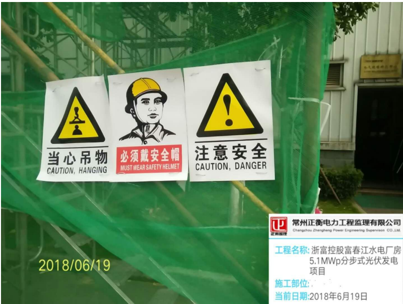
安全警示牌整改
