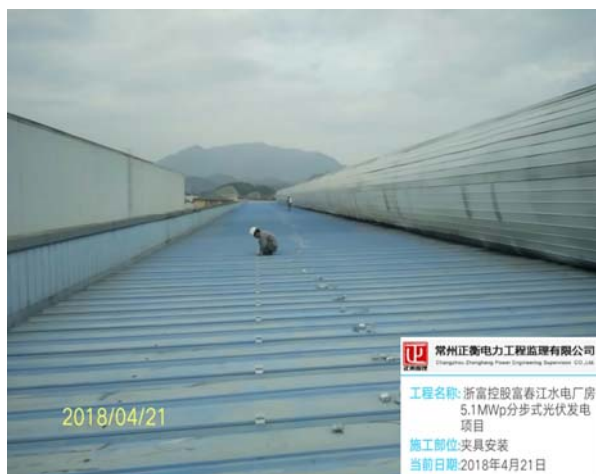
一期屋顶夹具安装
