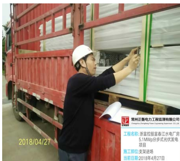
支架进场检查
