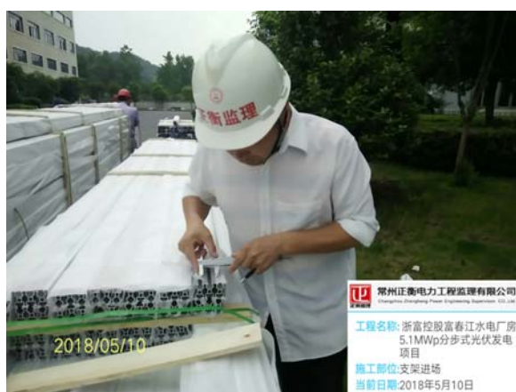
支架进场检查
