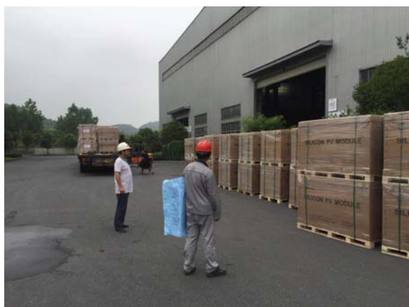
组件进场检查
