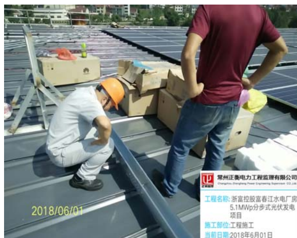
桥架安装检查
