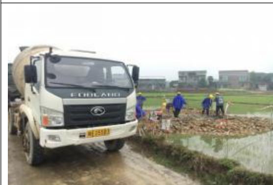
外线 33 号塔基浇筑
