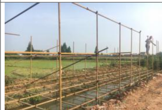
升压站临时工棚搭建
