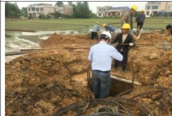
外线 13 号塔基基坑开挖、钢筋笼绑扎
