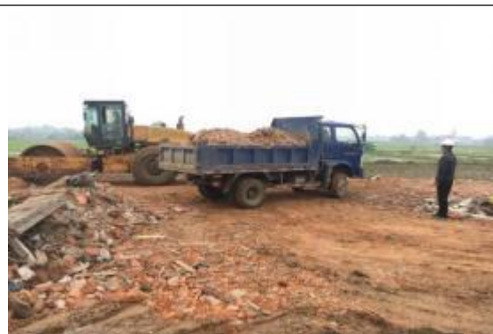
升压站进场道路铺筑
