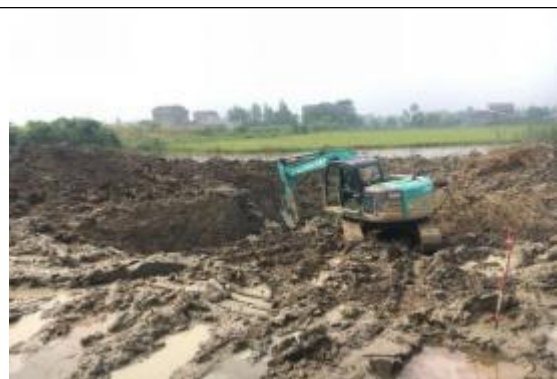
外线 35 号塔基基坑开挖
