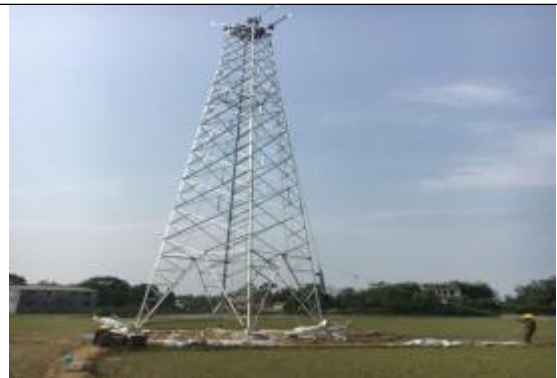
外线 31 号铁塔组立
