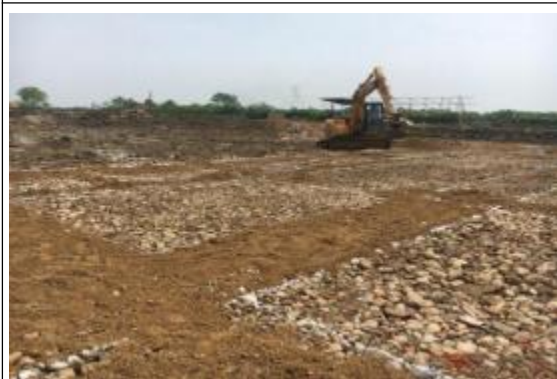
升压站基础回填
