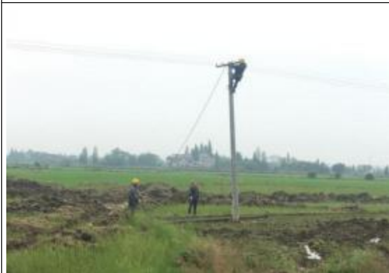
升压站临电线路架设
