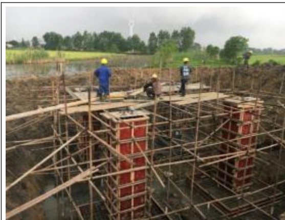
外线35号塔基浇筑
