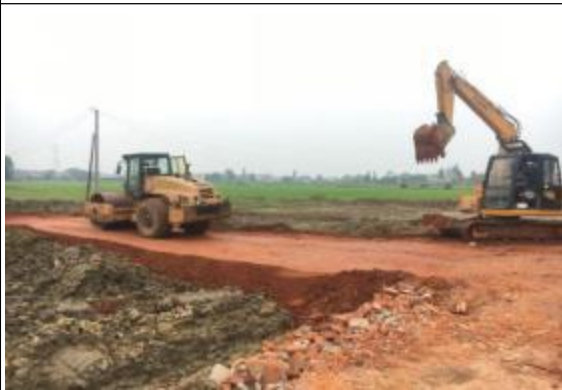
升压站循环道路铺筑
