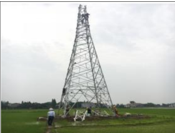
外线16号铁塔组立
