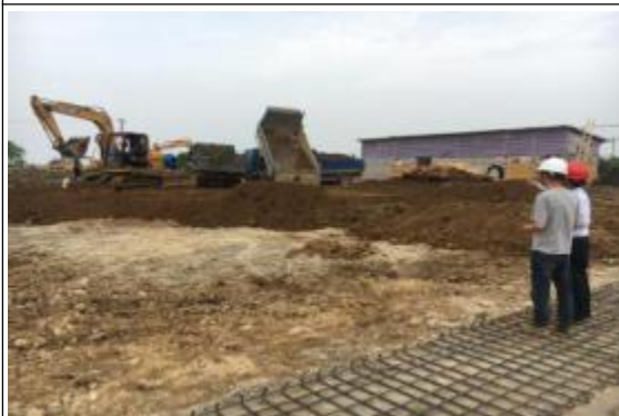
升压站土方回填
