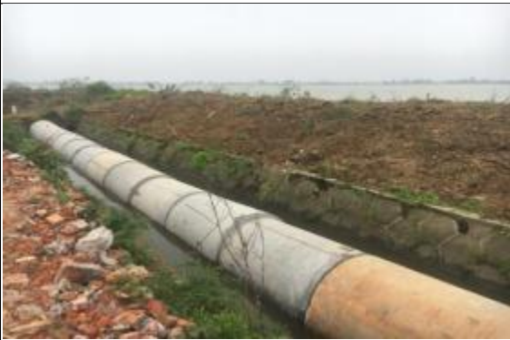
临时码头涵管就位
