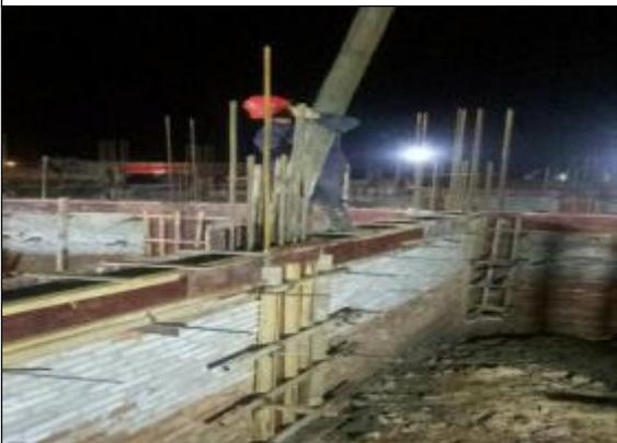
配电楼基础圈梁浇筑
