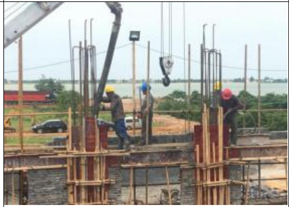
配电楼墙柱浇筑、一次室圈梁浇筑
