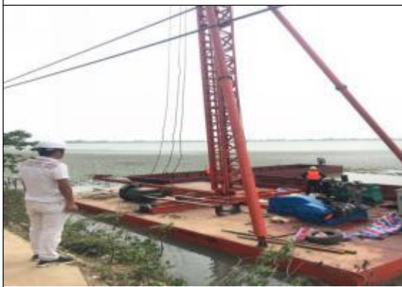
光伏区打桩浮船组装
