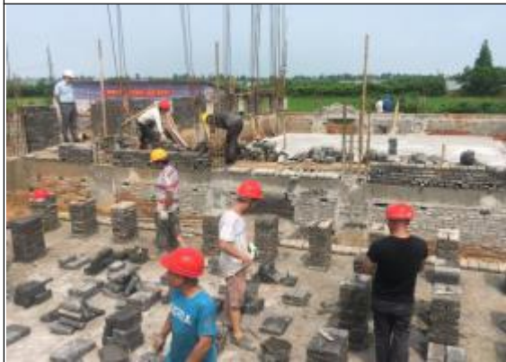
配电楼电缆沟砌砖
