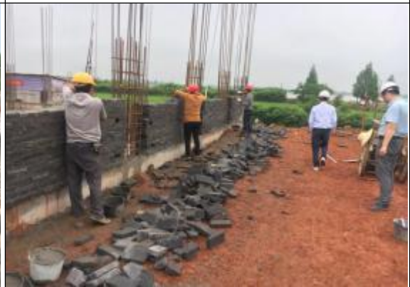
配电楼主体砌砖
