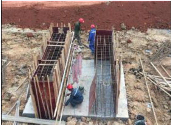
主变基础扎筋制模
