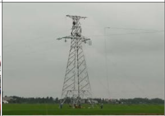
外线13-17号铁塔导线展放
