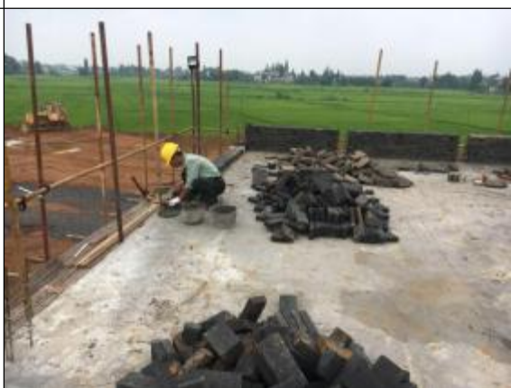
配电楼女儿墙砌砖
