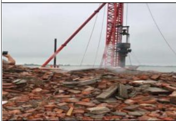
修建临时码头根管桩试打成功
