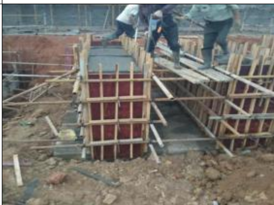
主变基础浇筑
