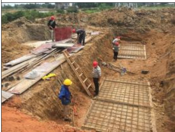
站内出线构架基础扎筋制模
