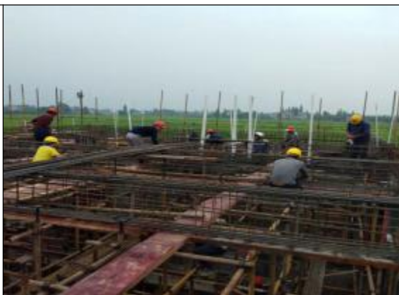
配电楼屋顶梁板钢筋绑扎
