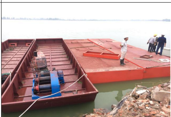
光伏区第二只浮船下水
