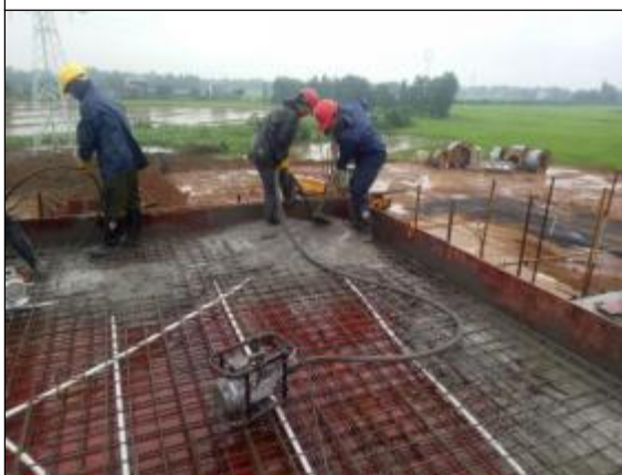
配电楼一次室屋顶梁板浇筑
