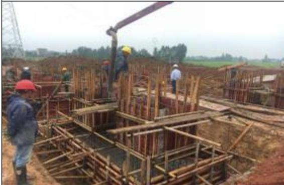
站内出线构架基础浇筑
