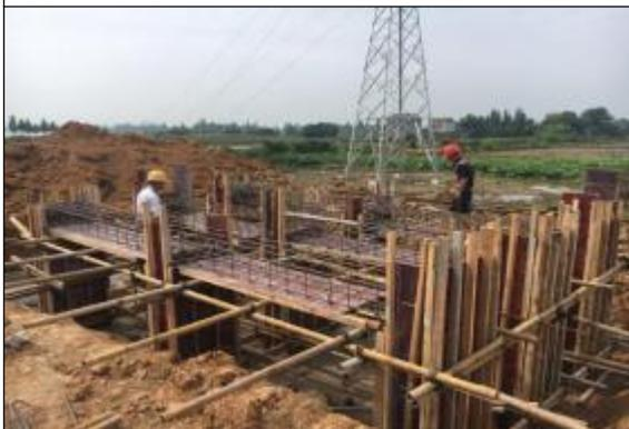
升压站接地变基础扎筋制模
