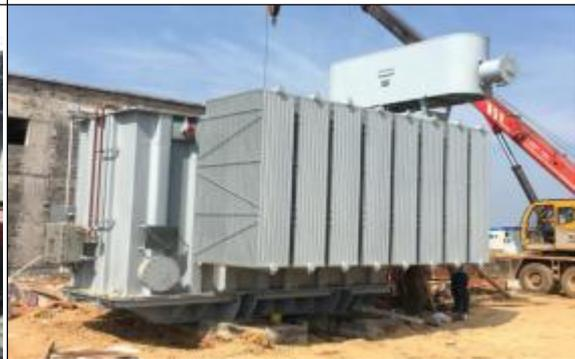
主变散热片、油枕安装完成
