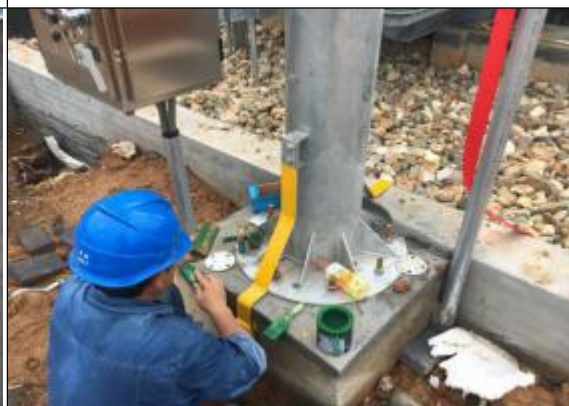
升压站户外设备刷接地标识漆
