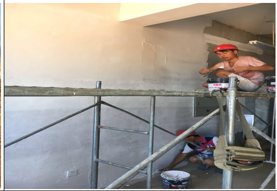
配电楼内墙刮腻子
