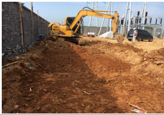
站内道路路基平整
