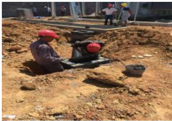
升压站排水系统施工
