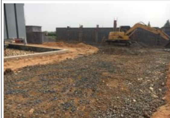
升压站站内道路碎石垫层铺筑
