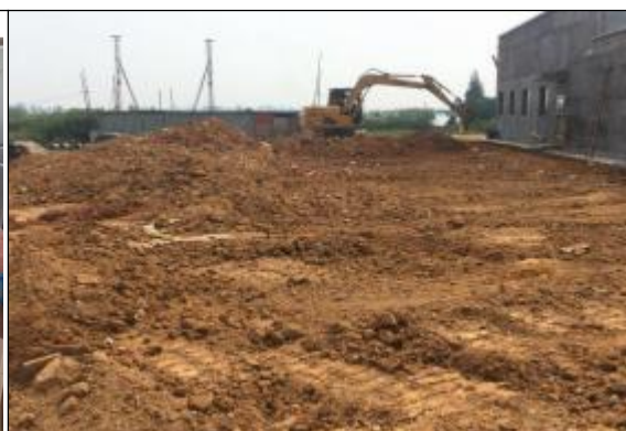
升压站配电楼区域场平
