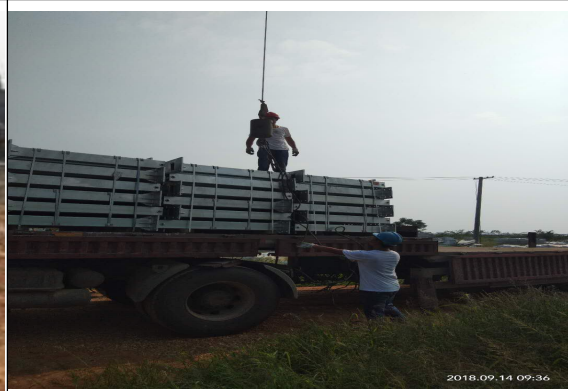
光伏支架进场吊卸
