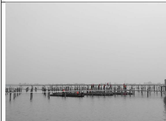
光伏区支架安装
