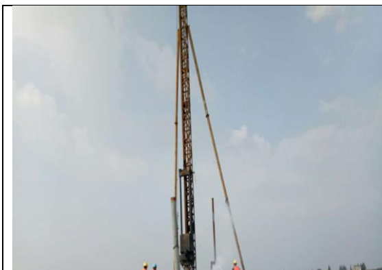
光伏区打桩施工
