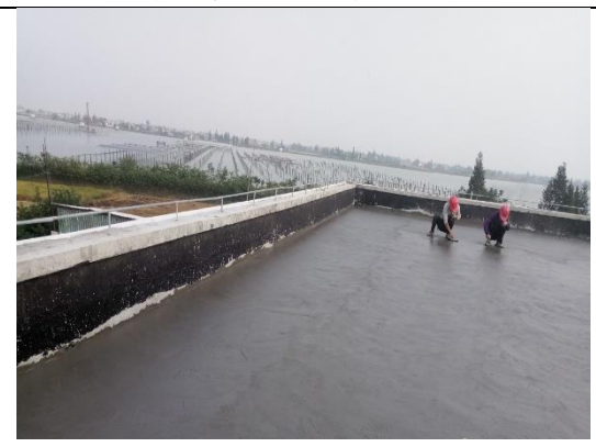
配电楼屋面混凝土面层压光
