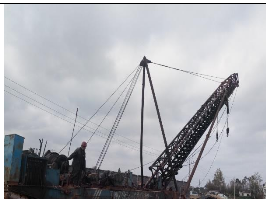
打桩机设备组装
