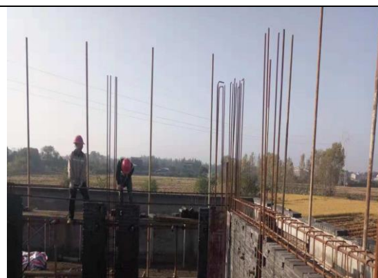
水泵房外墙圈梁钢筋绑扎
