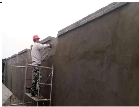
升压站围墙抹灰
