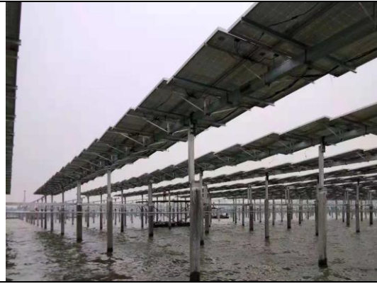
光伏区支架安装
