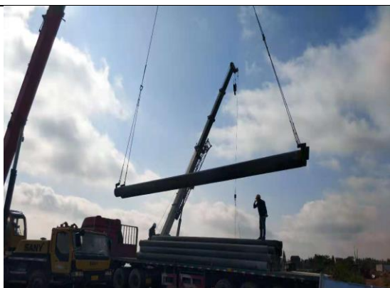
管桩材料吊装
