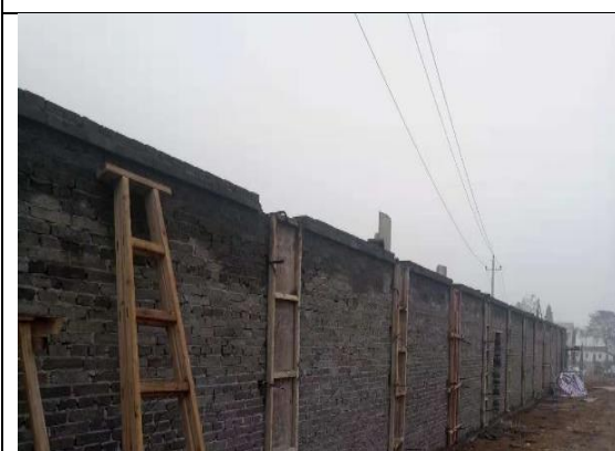
西侧围墙构造柱浇筑完成
