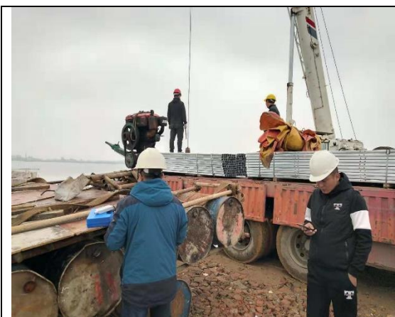
光伏区支架材料到货
