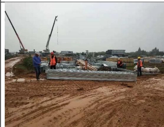
光伏区支架材料倒运
