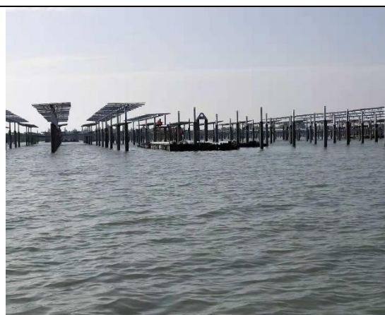
光伏区支架安装
