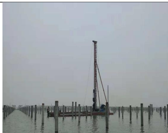
光伏区打桩施工
