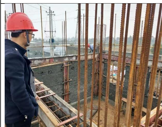
圈梁、柱混凝土浇筑
