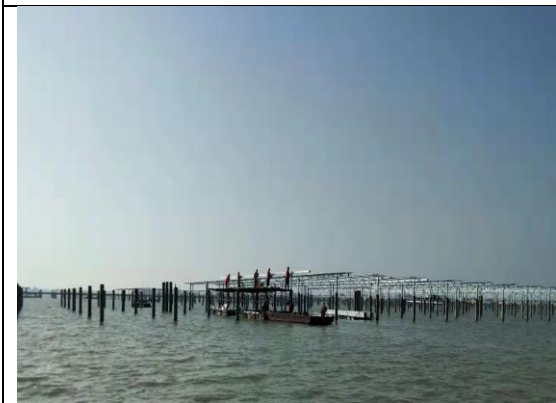
光伏区支架安装
