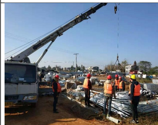
光伏区支架材料吊装
