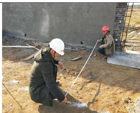
综合楼管桩基础定位复测
