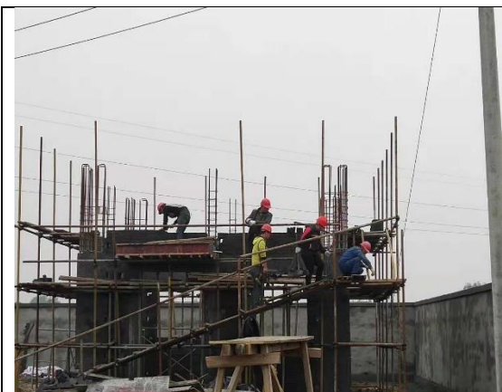
升压站水泵房外墙砌筑
