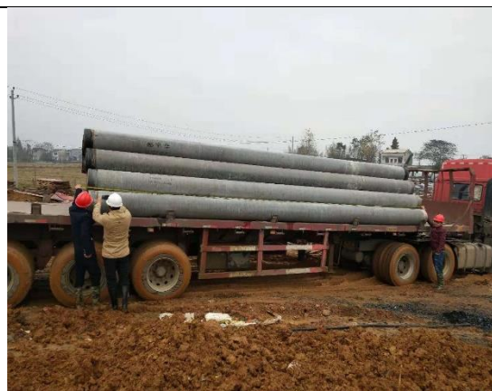
综合楼管桩到货检查
