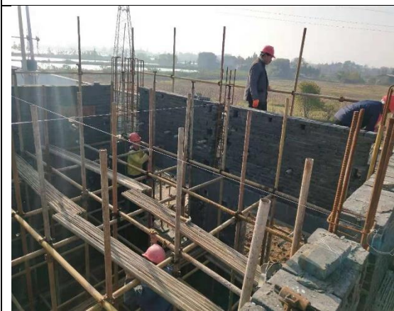
升压站水泵房支模绑扎
