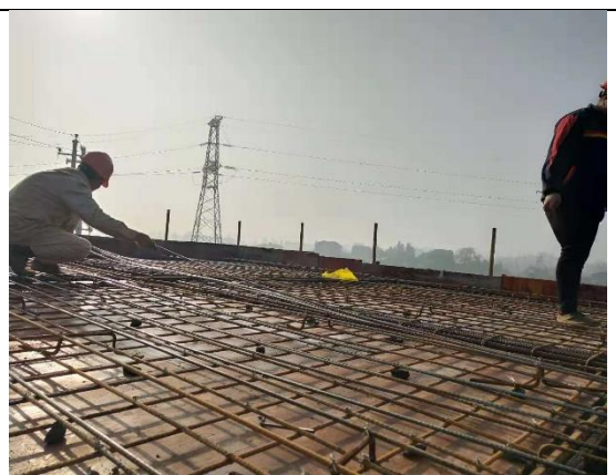
水泵房顶板钢筋绑扎
