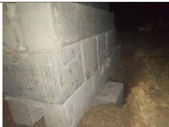
综合楼管桩静压桩试验
