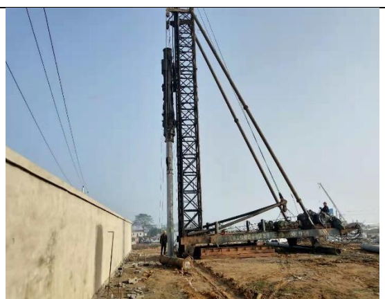
综合楼基础打桩施工
