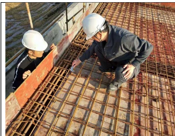
水泵房顶板钢筋检查
