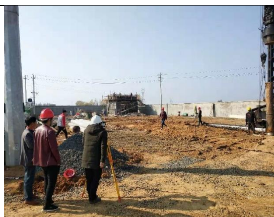
复测综合楼桩位标高
