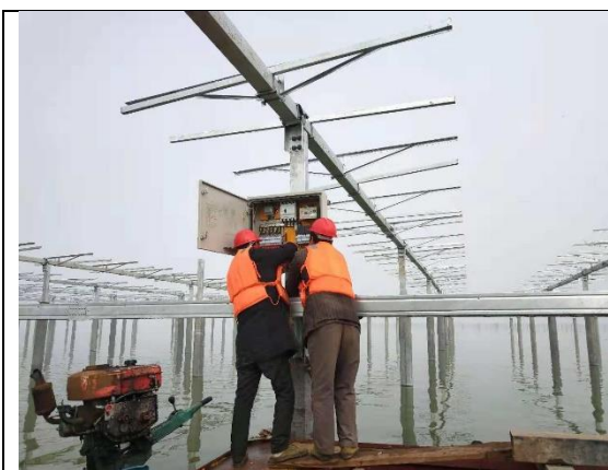
光伏区汇流箱安装
