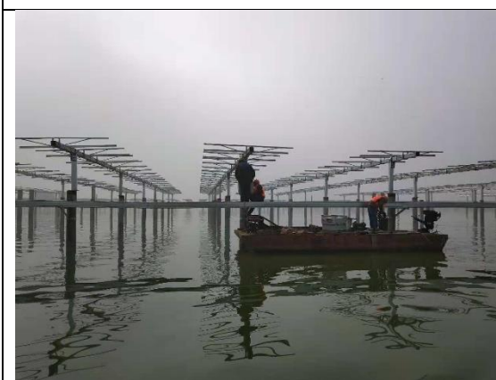
光伏区汇流箱安装
