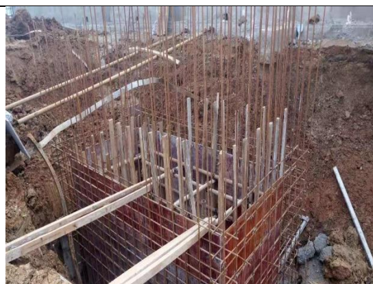
污水池、调节池钢筋绑扎、支模
