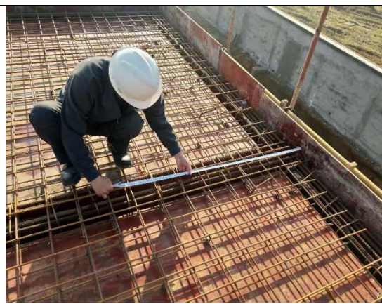
水泵房顶板钢筋检查
