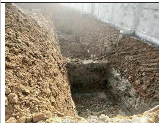
污水处理装置基础开挖
