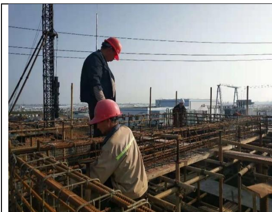
升压站水泵房梁钢筋绑扎
