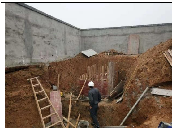
污水池、调节池钢筋绑扎、支模
