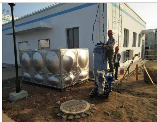
水泵房水箱到场
