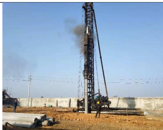
综合楼基础打桩施工
