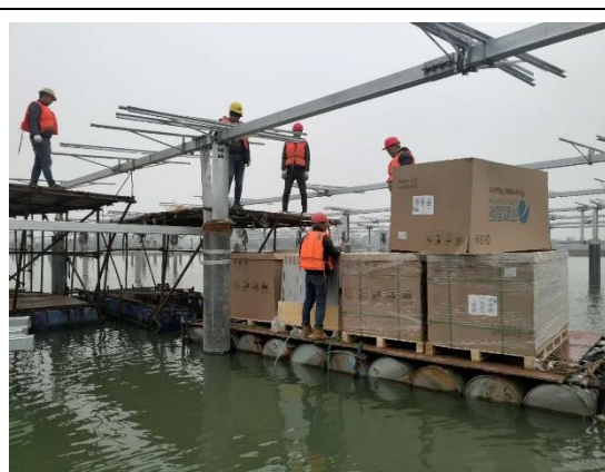
光伏区组件安装
