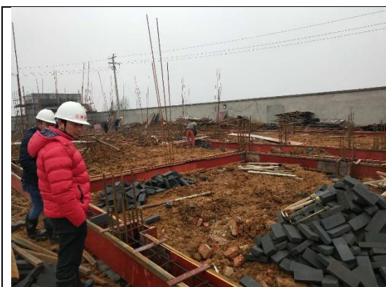
办公楼圈梁支模钢筋绑扎
