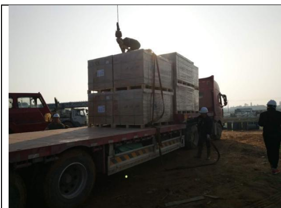
光伏区组件到场卸货
