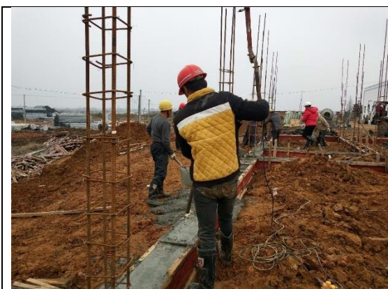
办公楼圈梁浇筑
