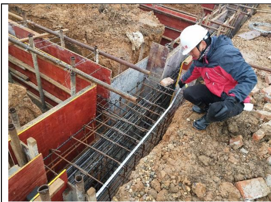
检查综合楼基础钢筋绑扎
