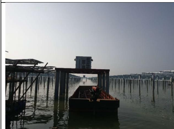
光伏区逆变器就位
