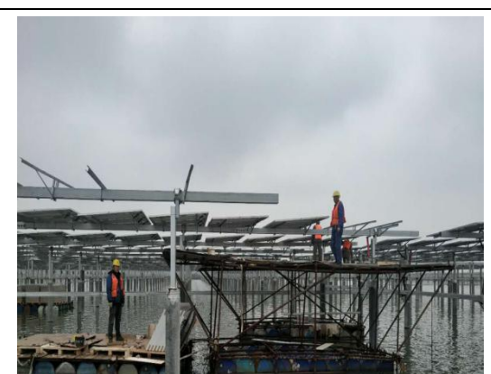
光伏区组件安装
