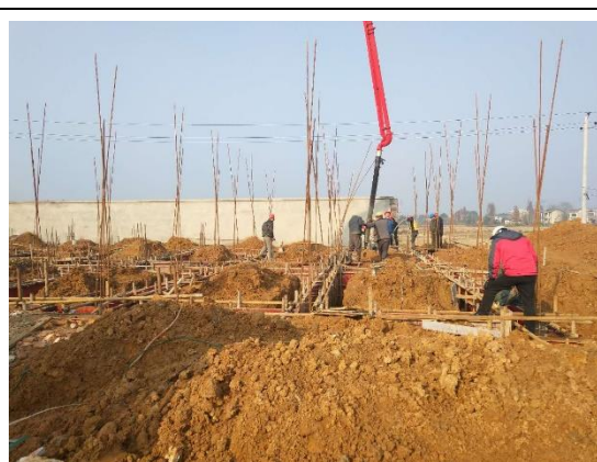
综合楼基础混凝土浇筑
