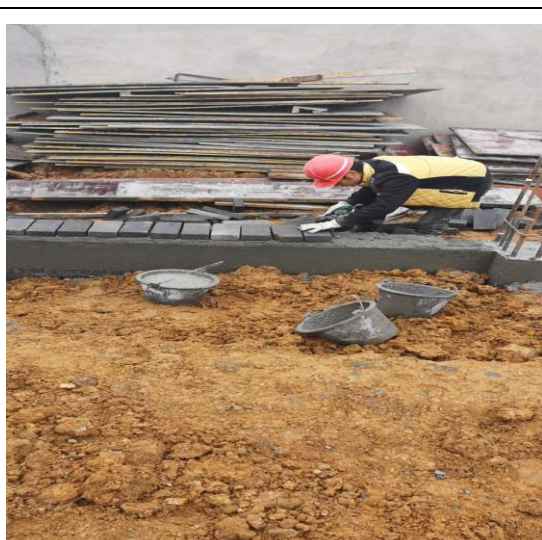
办公楼圈梁砌砖
