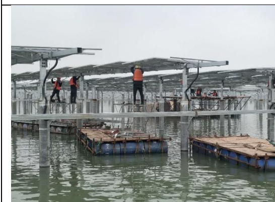
光伏区组件安装
