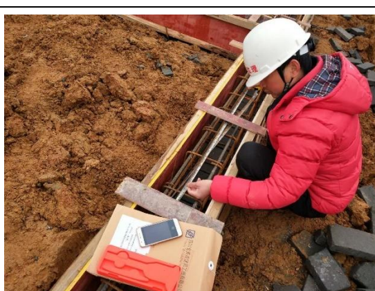
办公楼圈梁钢筋检查
