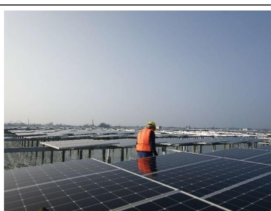
光伏区组件安装
