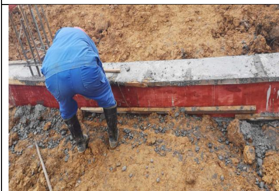
办公楼圈梁拆模
