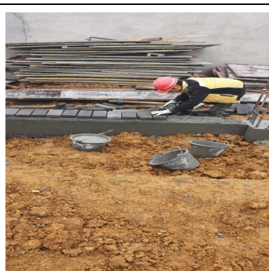
办公楼圈梁砌砖
