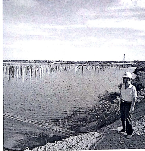
光伏区巡视检查
