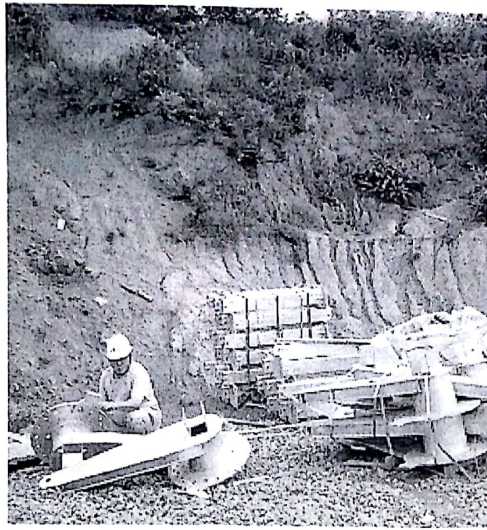
光伏区材料检查
