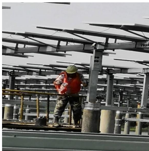
光伏区桩头刷防腐漆
