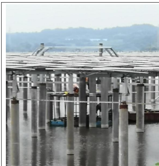
现场组件接地施工
