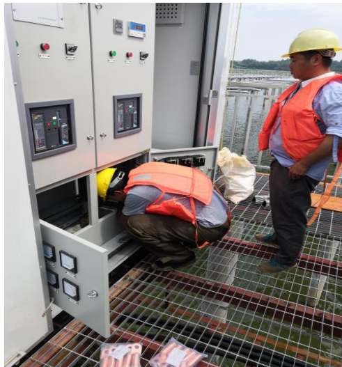
箱逆变器电缆线端接
