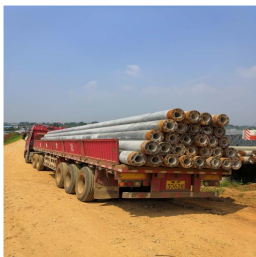
光伏区支架、管桩材料进场
