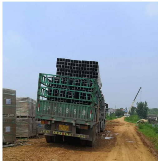
光伏区支架、管桩材料进场
