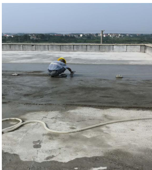
开关站综合楼屋面消缺
