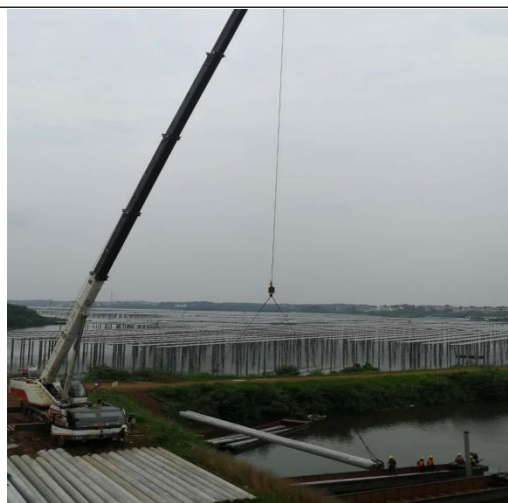
现场管桩吊运
