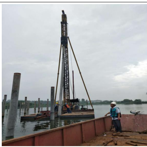
光伏区桩基打桩
