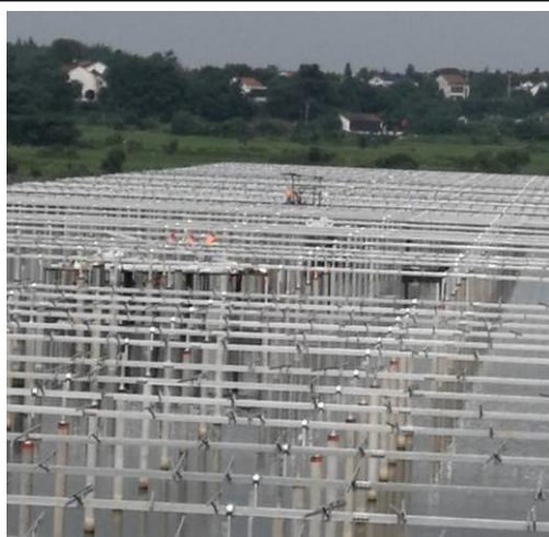
现场支架安装
