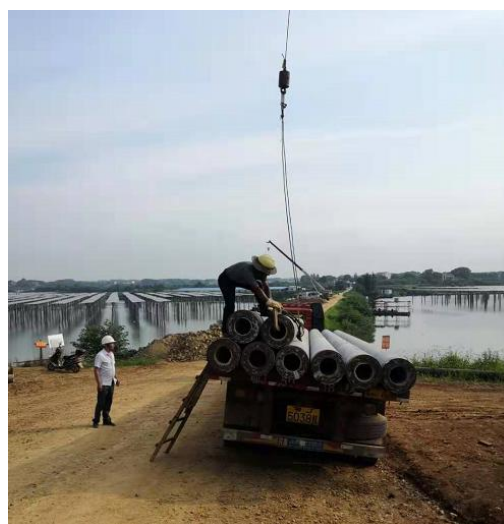
管桩材料进场
