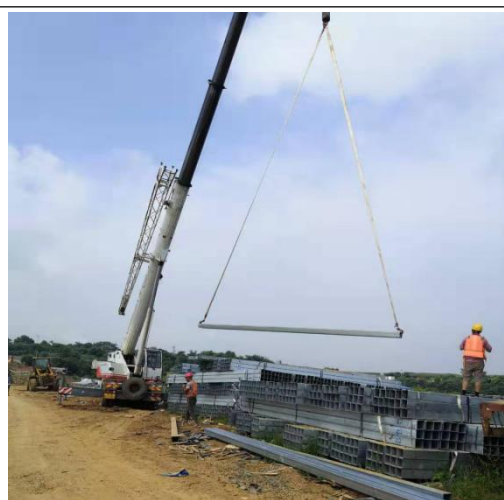
现场逆变器、支架材料吊运
