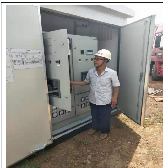
箱变材料进场并进行开箱检查
