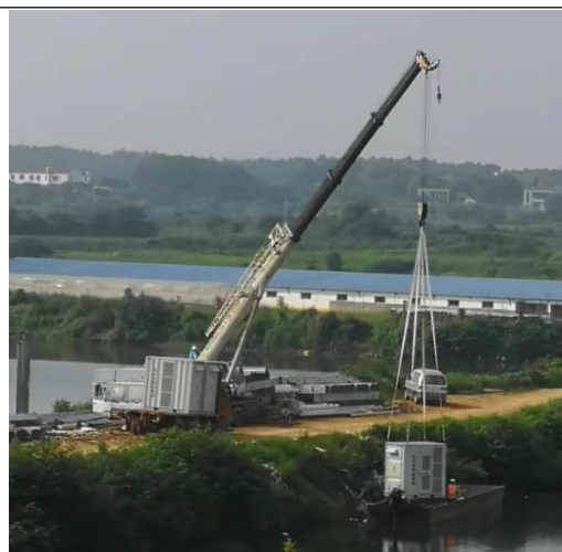
现场逆变器、支架材料吊运
