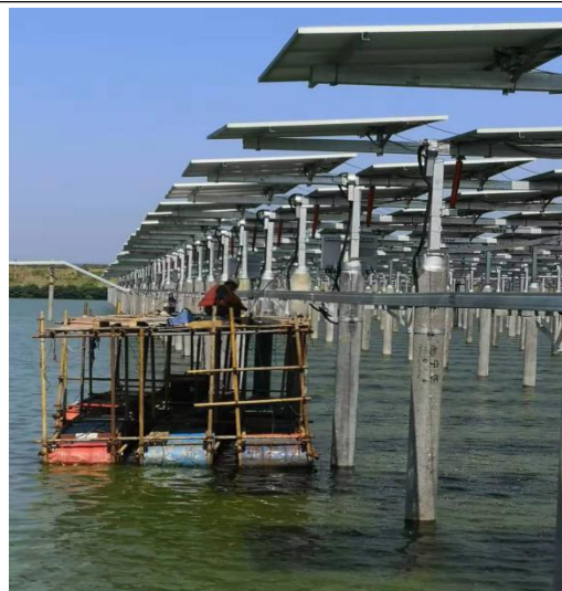
光伏区接地焊接
