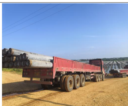
光伏区管桩进场
