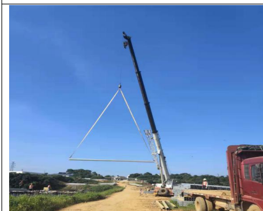
现场材料吊运
