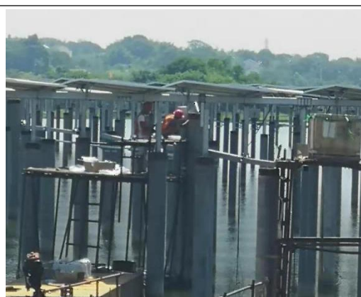
现场驱动机电源线端接
