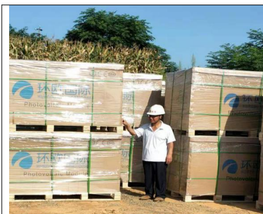
光伏区组件进场
