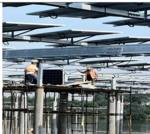
光伏区组件安装
