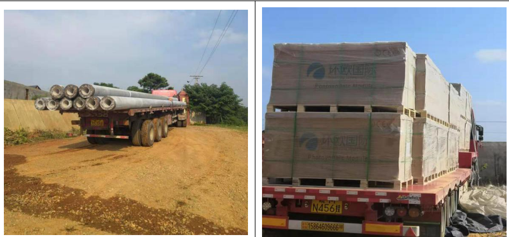
现场组件、管桩材料进场
