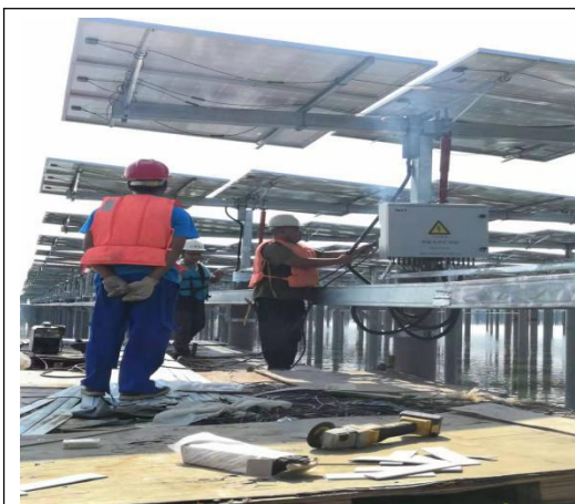
光伏区接地扁铁焊接
