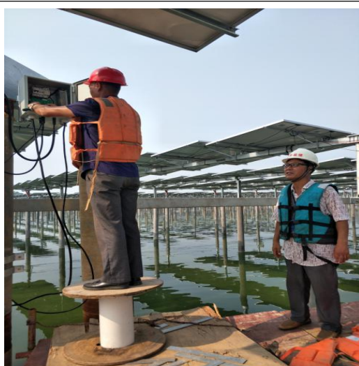
光伏区驱动器调试
