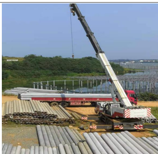
光伏区管桩进场吊运
