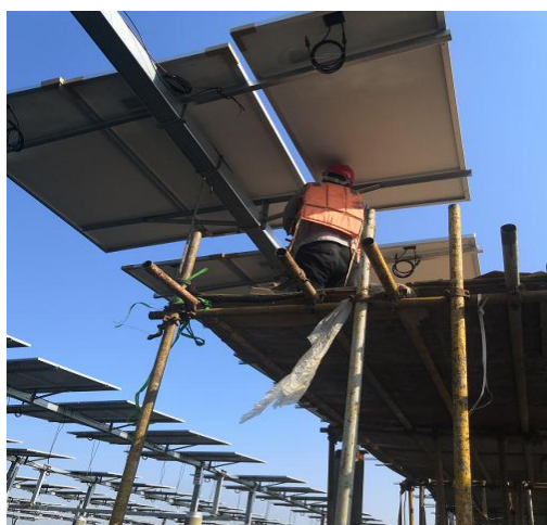
光伏区组件消缺
