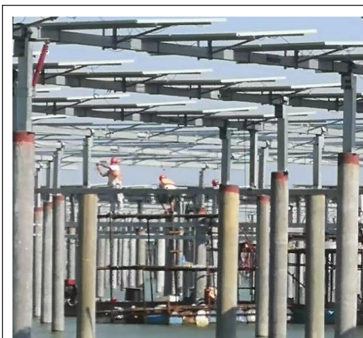
光伏区支架消缺
