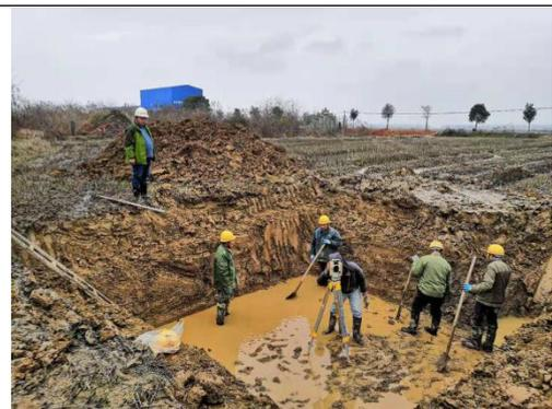
南琴线 41 号塔基基础开挖
