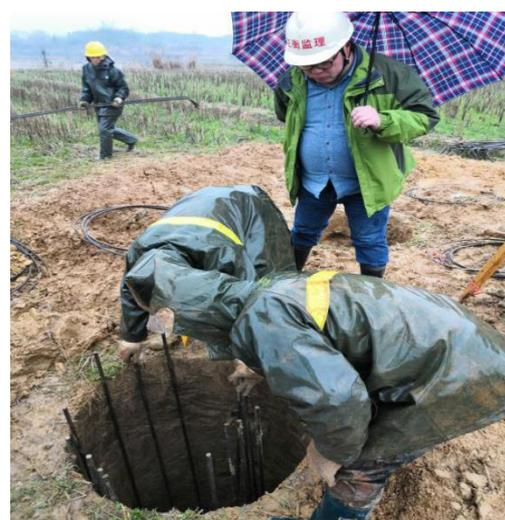
南琴线 22#塔基基础绑扎钢筋
