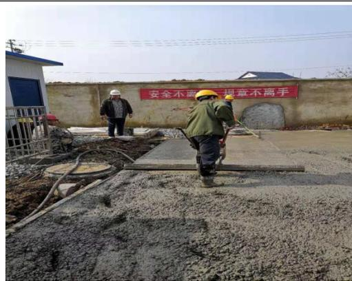
开关站道路及场区地面混凝土浇筑
