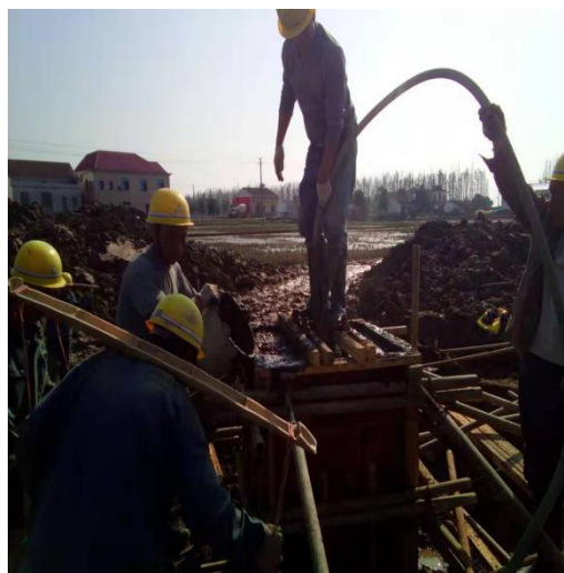
南琴线 50 号塔基浇筑
