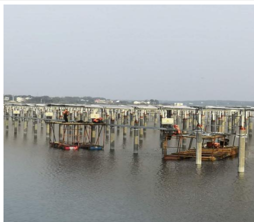
24 区 1*4 电缆线敷设
