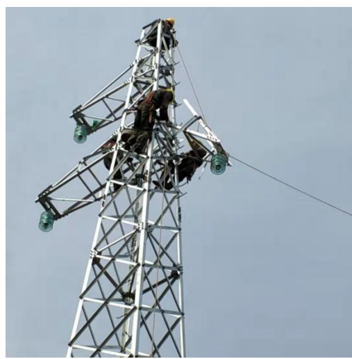
南琴线 5 号铁塔安装
