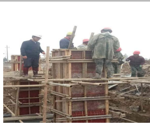
对 52 号塔基浇筑混凝土旁站
