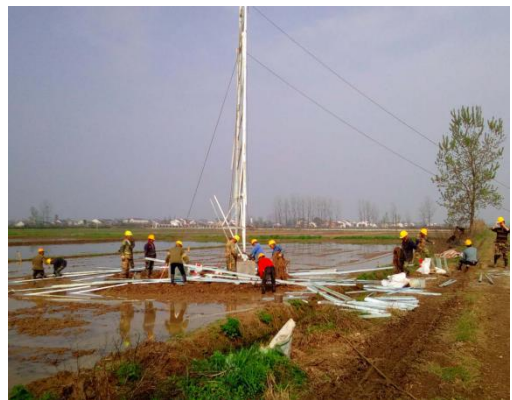
南琴线 47 号铁塔安装
