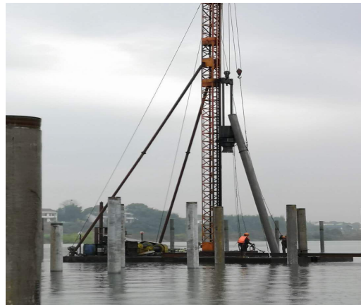
光伏区 14 区打桩
