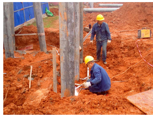
琴棋变对侧焊接设备接地
