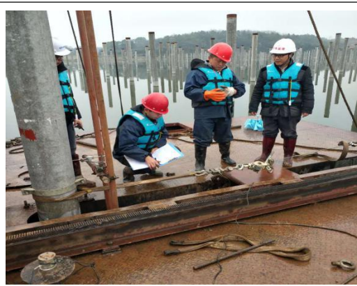
对光伏区桩基做拉力试验检查
