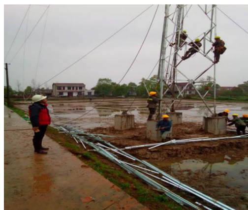
南琴线 51#铁塔安装
