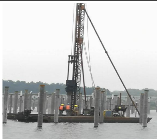
光伏区桩基打桩
