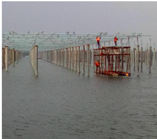
光伏区现场支架安装
