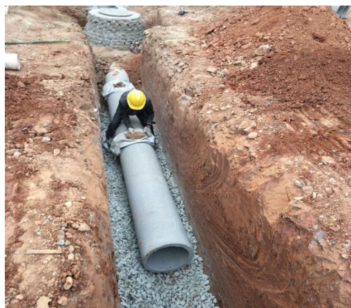
开关站室外排水管安装
