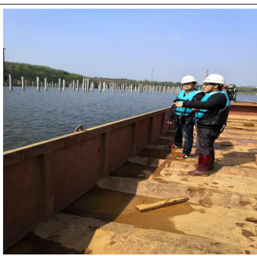
对光伏区施工进行巡视检查
