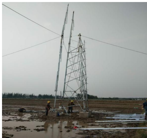
南琴线现场铁塔安装
