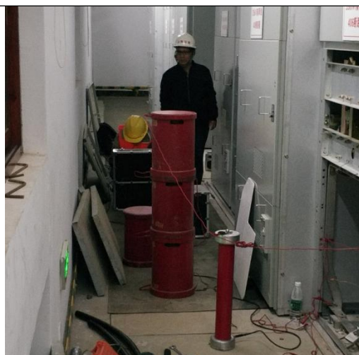
对高压电缆做耐压试验旁站
