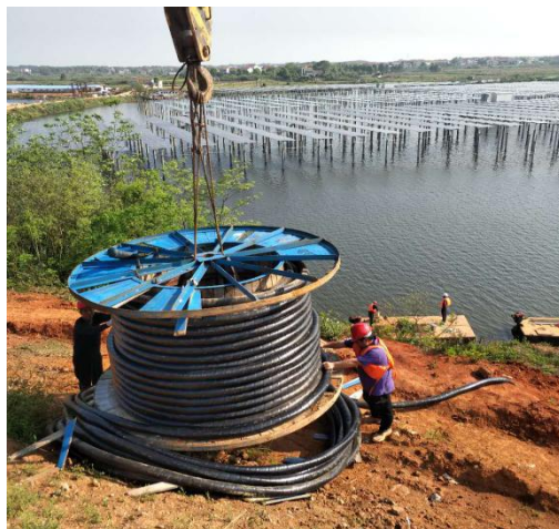
22 区、25 区集电线路敷设
